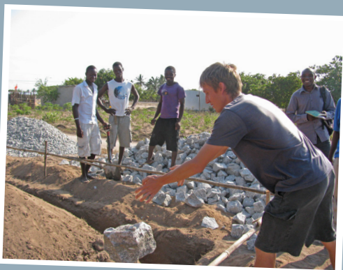
Baubeginn eines Lagerhauses, Mocuba, Mosambik, 2013, ©Marlise Schlötterer
